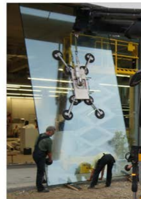
Kraftschlüssiger Vakuumheber für den Glastransport
