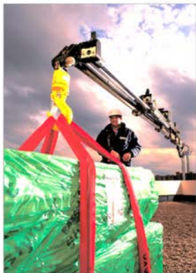
Tragmittel Kranhaken, Anschlagmittel Hebeband
